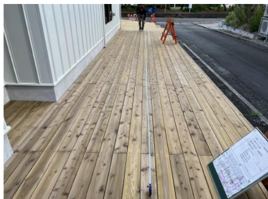
ウッドデッキの施工例
