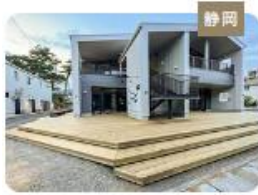
店舗：ウッドデッキ:エクステリア
