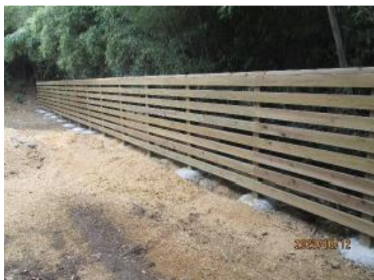
木塀の施工例
